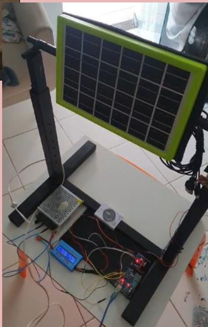
Figura 42-Acoplamento do painel fotovoltaico
